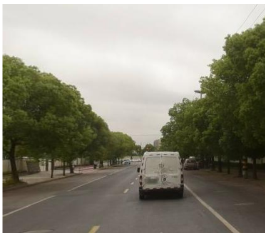
北侧的常和路
